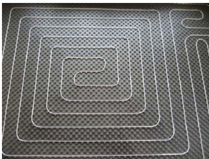
Bifilare Verlegung mit Noppenplatten
